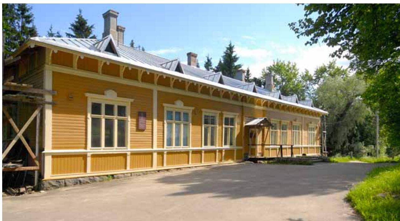
Здание Краеведческого центра
