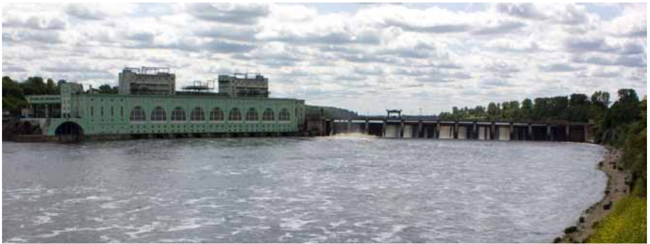
Г. Волхов. ГЭС на р. Волхов
